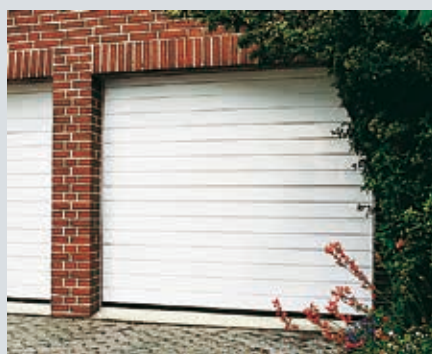
Einbau hinter der Öffnung Klinker/Verblender als Seitenanschlag
