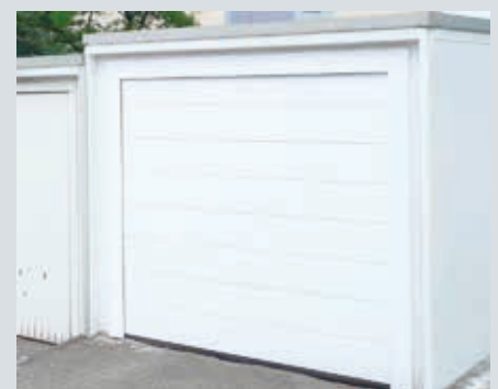
Einbau vor der Öffnung bei Beton-Fertigaragen
